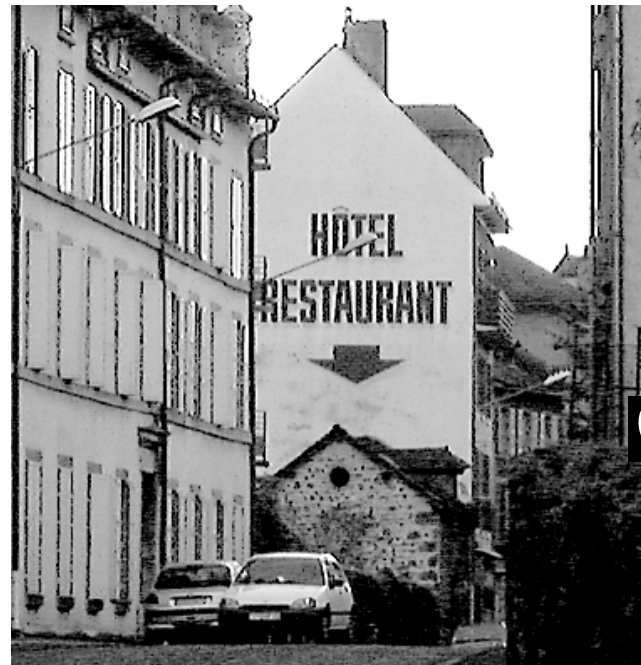
Enseigne murale peinte bien lisible tout en étant moins agressive qu'un dispositif lumineux. La dimension des lettres paraît excessive. Le soir, ce type de mur peut être éclairé par des spots extérieurs.
