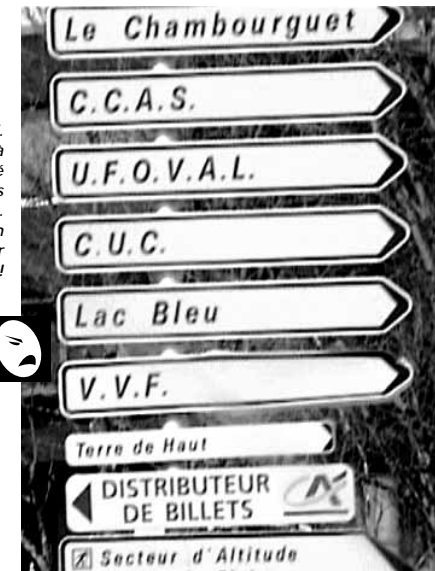
Jalonnement DDE. Le mât déjà surchargé a été "accaparé" par des barrettes diverses. Une organisation s'impose pour aider à la lisibilité !
